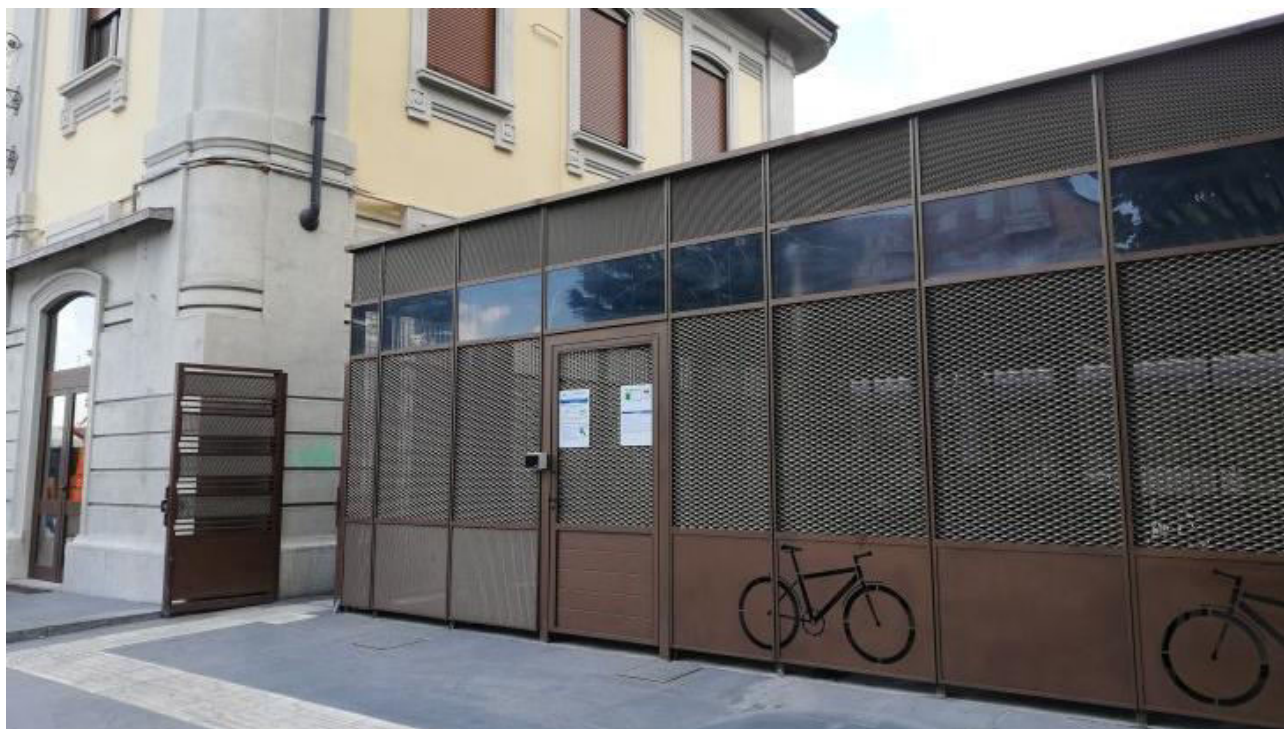
Figura 2-35 Velostazione realizzata presso la stazione ferroviaria di Busto Arsizio
